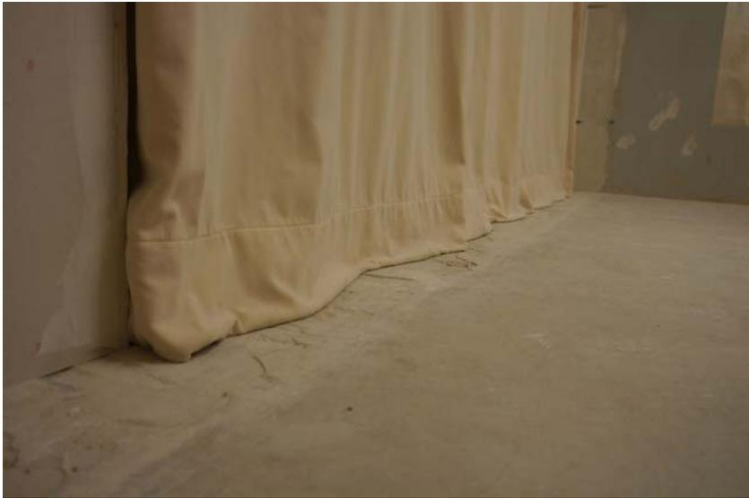
Abbildung B.3. Beschwerter Saum der Decklage, die auf dem Boden aufliegt.
