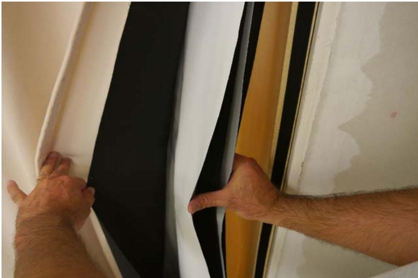
Abbildung B.4. Decklagen und Innenlagen des Schallvorhangs.
